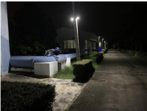
รูปแสดงการติดตั้งไฟทางเดินโดยใช้หลอด LED ที่สถานีผลิตน้ำบางบาล
